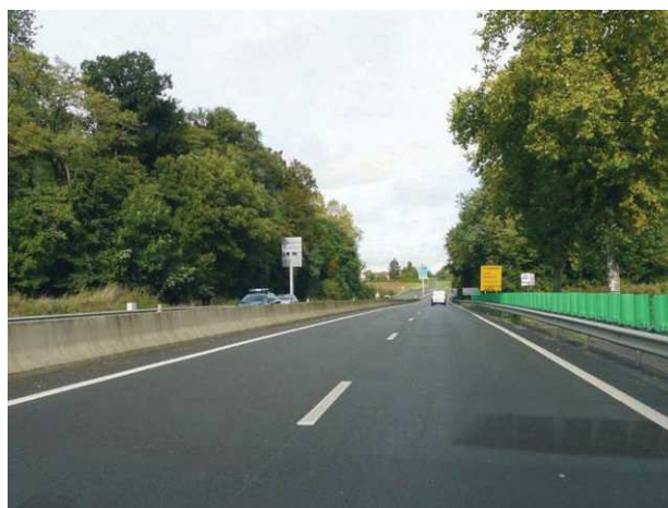
Photo 4 : D1016 à la traversée du bois de Saint Just. La route est au niveau du terrain naturel. Une glissière en béton armée a été posée au centre des voies ce qui représente une forte contrainte pour la traversée de la faune terrestre, même les grands mammifères. ©O.G.E./V. Vignon
