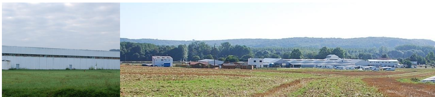
Ancienne usine AVON
